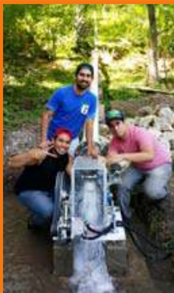
Andrés Ortega, Dominik Plata y José Antonio Cuevas en la instalación de la Microcentral Hidráulica en Tzimol, Chiapas
